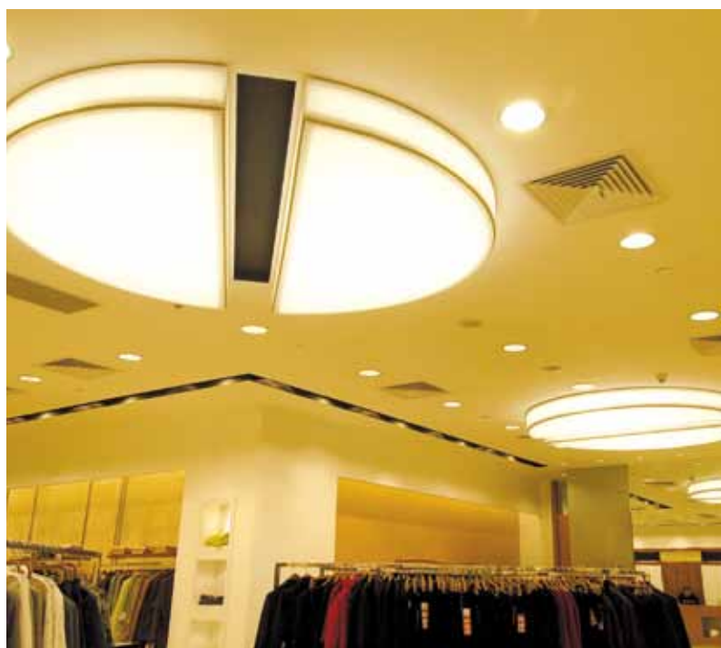
lumières Barrisol® - architecte : Saadettin YÜKSEL / APEKS design
